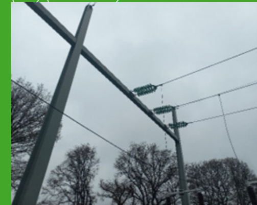
Foto 18: coating op staalconstructie hoogspanningsinstallaties (chrom-6)
