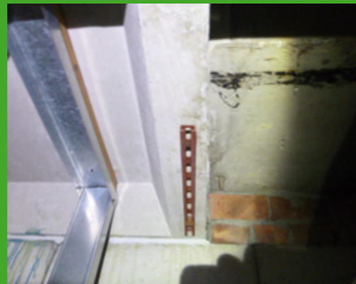
Foto 4: coating op stalen montagestrip (chrom-6)
