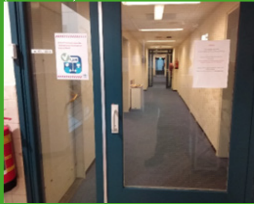
Foto 22: coating op stalen kozijnen (chrom-6)
