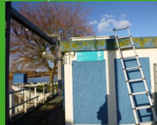
Foto 17: coating op betonconstructie (blauw) (chrom-6)
