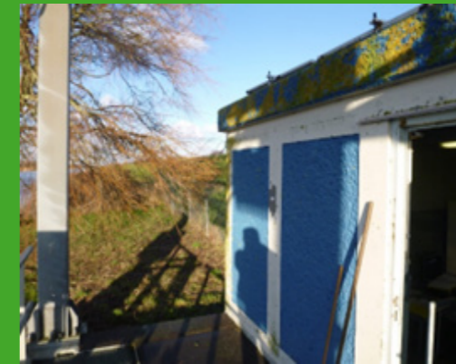
Foto 16: coating op betonconstructie (wit) (chrom-6)
